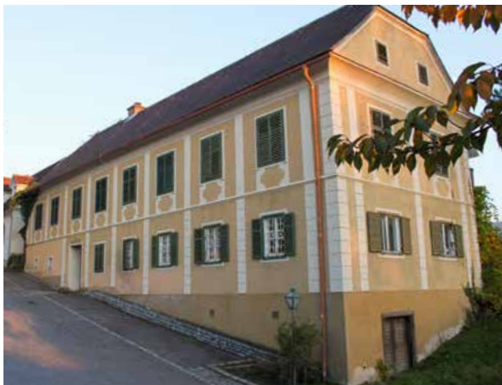
■ Alter Pfarrhof vor der Sanierung 2012
